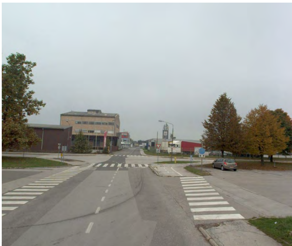
Slika 61: Neustrezen zaključek kolesarske steze (vodenje kolesarjev v nasprotno smer)
